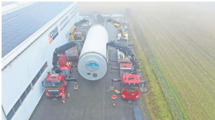
Gewusst wie: Die grosse, 48 Tonnen schwere Trommel wird von vier LKW-Kränen angehoben. Danach kann der Anhänger rückwärts unter die Trommel gefahren werden.
